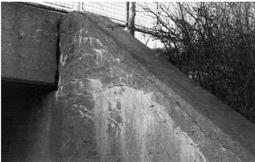
Рисунок 6 – Типичный характер повреждений, вызванных щелоче-кремнеземной реакцией [35]
