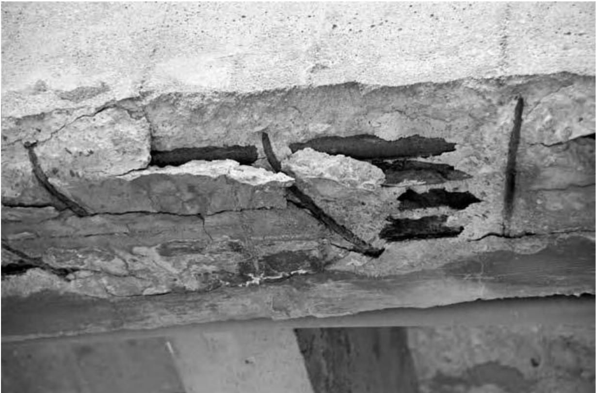
Рисунок 10– Разрушение железобетонного элемента мостовой конструкции, вызванное коррозией арматуры (причина коррозии – карбонизация защитного слоя бетона, проникновение хлоридов) [45]
