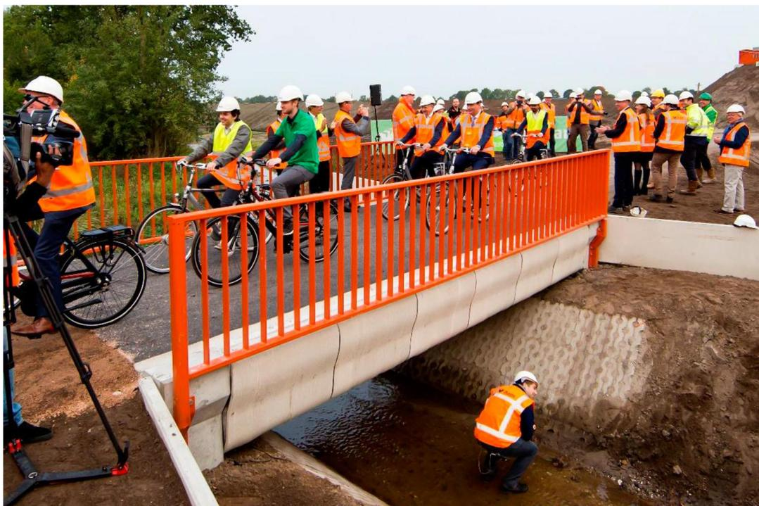
Рисунок 4 – Велосипедный мост, собранный из элементов, изготовленных с помощью 3D-печати (Голландия) [13]
